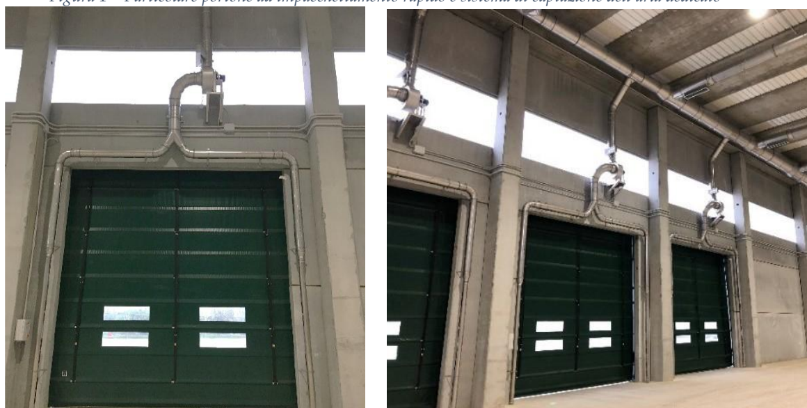
Figura 1 – Particolare portone ad impacchettamento rapido e sistema di captazione dell'aria dedicato
